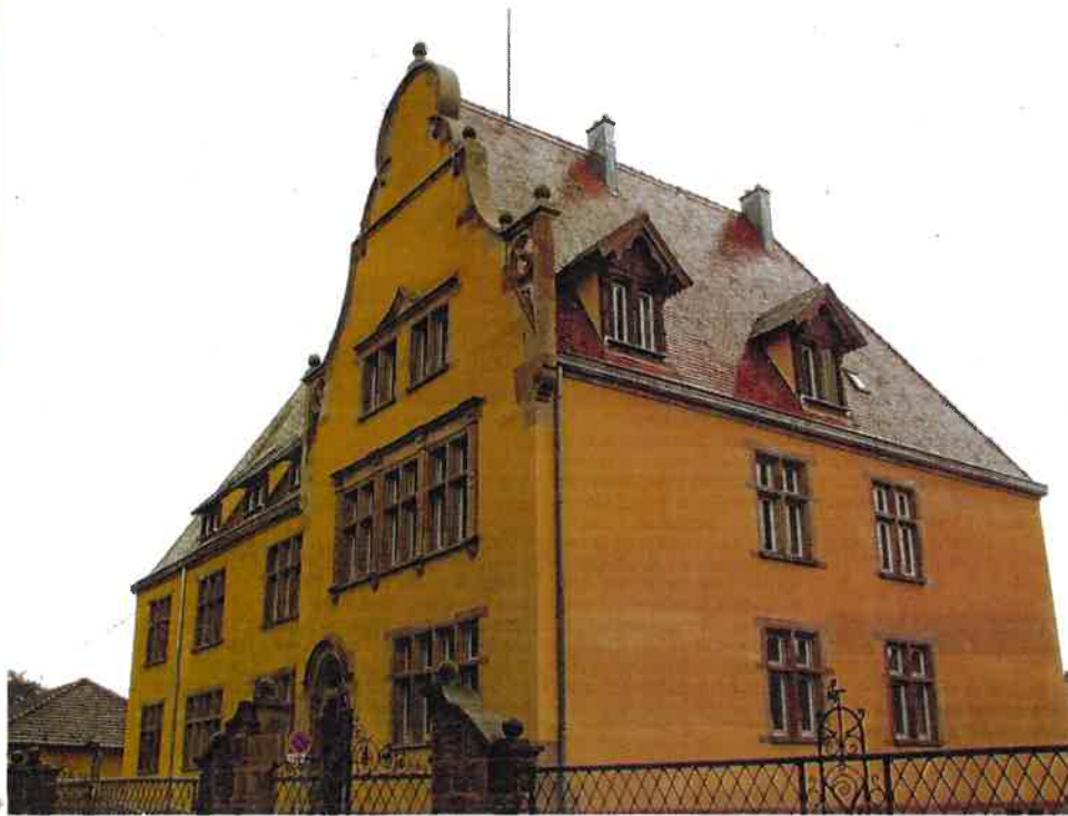
L'ancien tribunal de Cernay a été transformé en résidence sociale. PHOTOS DNA - FRÉDÉRIC STENGER
