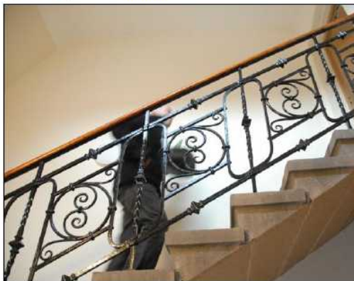
Les ferronneries de la cage d'escalier intérieure ont été traitées et repeintes.
