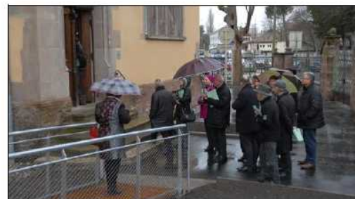
Une rampe d'accès permet aux personnes à mobilité réduite d'accéder à la médecine du travail, dont l'entrée se situe à l'avant du bâtiment.
